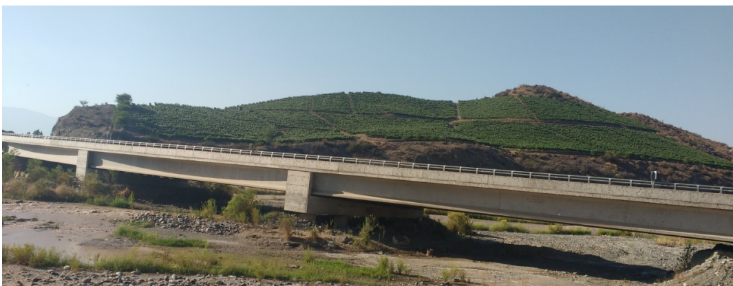
PUENTE-AUTOPISTA SOBRE RIO ACONCAGUA- COQUIMBITO-CALLE LARGA-LOS ANDES
