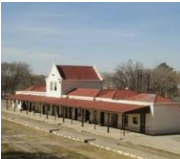
ESTACION FERROVIARIA-VILLA MERCEDES-SAN LUIS
